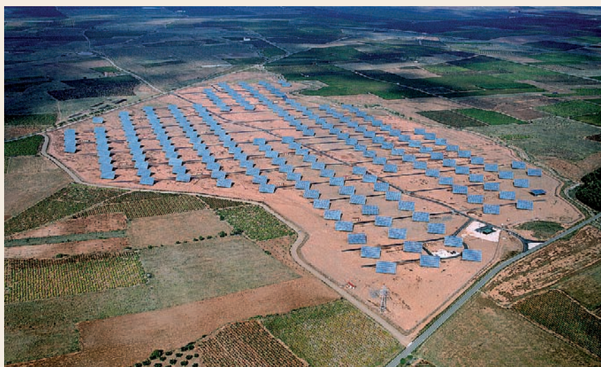
■ Parque Fotovoltaico de Almonacid de la Sierra
