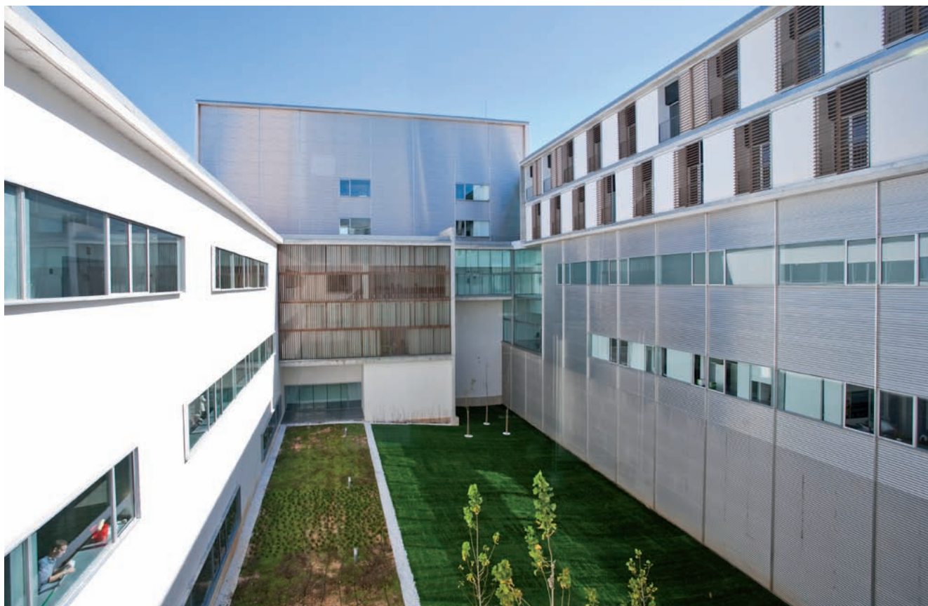
■ Hospital Marina Salud de Denia (Alicante). Propiedad y gestionado por DKV.
