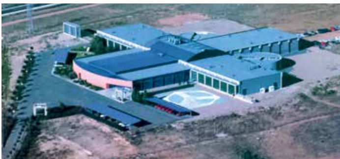
> Vista aérea del Centro Zaragoza.
